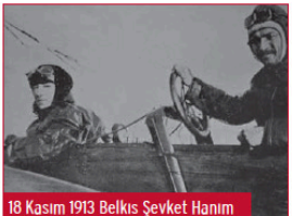
18 Kasım 1913 Belkıs Şevket Hanım
