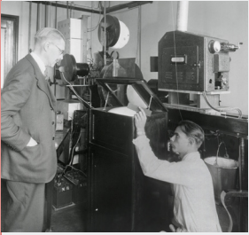
Kapalı bir resim tüpünün görüntüsünü yansıtan bir dikiz aynasına sahip ilk televizyon çalışmaları.
