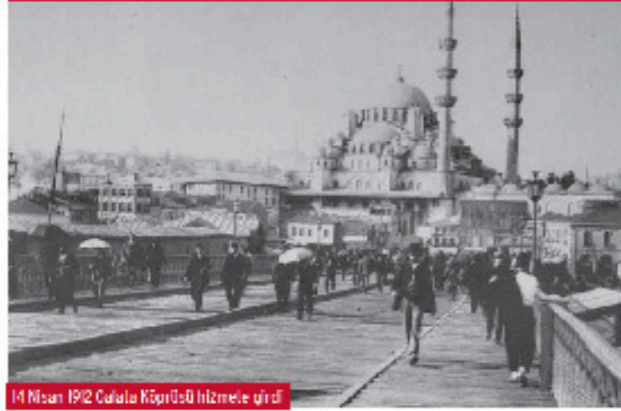
14 Nisan 1912 Galata Köprüsü hizmete girdi
